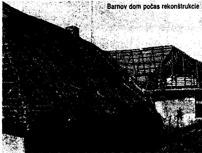
Barnov dom počas rekonštrukcie
