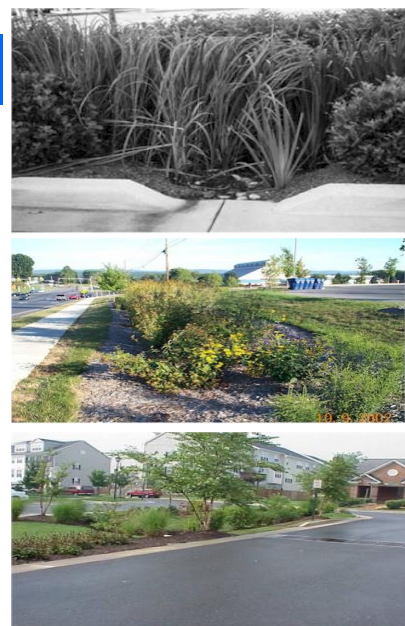
Obr. č. 13 Odvádzanie dažďovej vody z ciest do príľahlých priekop a parkov (archív MVO Ľudia a voda)
