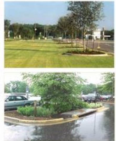
Obr. č. 12 Systémy zbierania dažďovej vody do koreňového systému stromov (archív MVO Ludia a voda)
