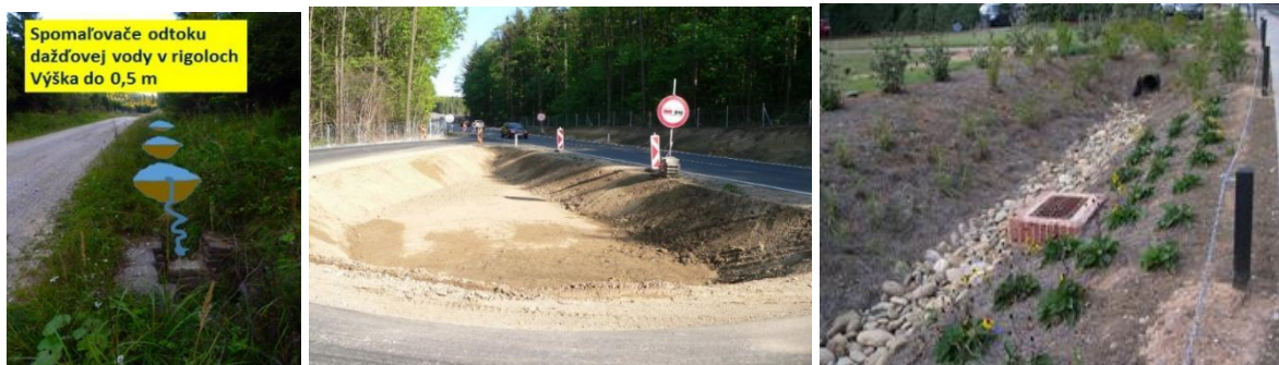
Obr. č. 26 Schémy infiltračnej priekopy pozdĺž cesty, príklady aplikácie a zbierania dažďovej vody v rigoloch z USA a Rakúska (archív MVO Ľudia a voda)
